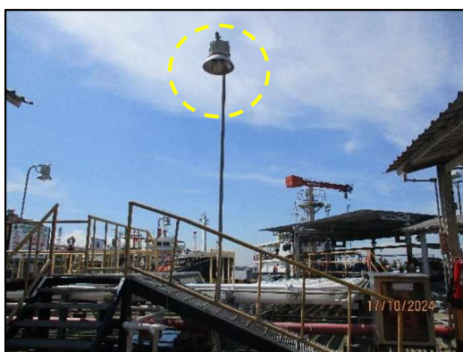
ภาพถ่ายที่ 2.2-9 ไฟแสดงขอบเขตท่าเทียบเรือ และไฟให้แสงสว่างบริเวณท่าเทียบเรือ
