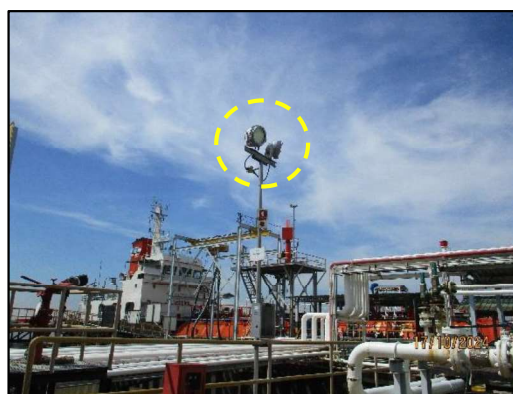
ภาพถ่ายที่ 2.2-9 ไฟแสดงขอบเขตท่าเทียบเรือ และไฟให้แสงสว่างบริเวณท่าเทียบเรือ
